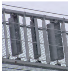
図2 地吹雪による視程障害対策用風車
