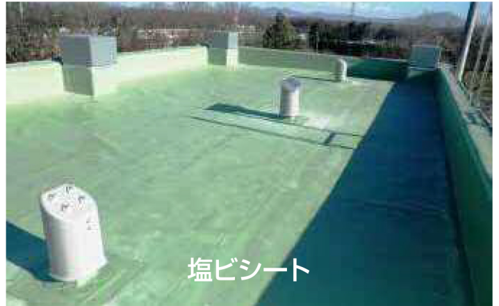
機械固定シート防水工法
