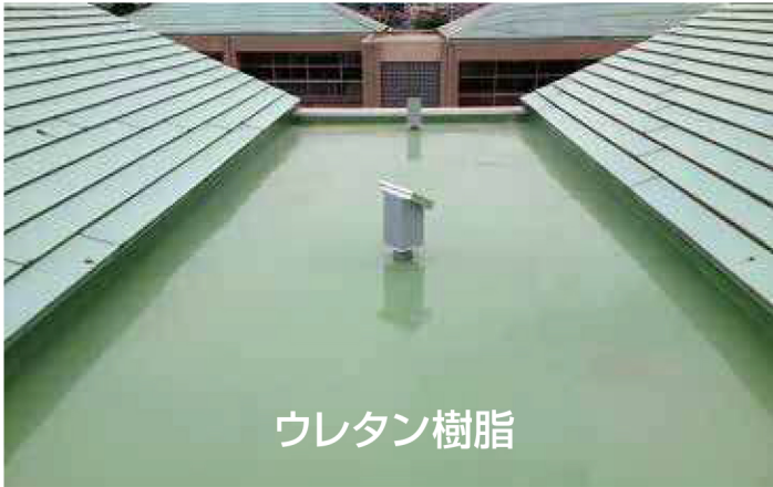
塗膜系防水工法
